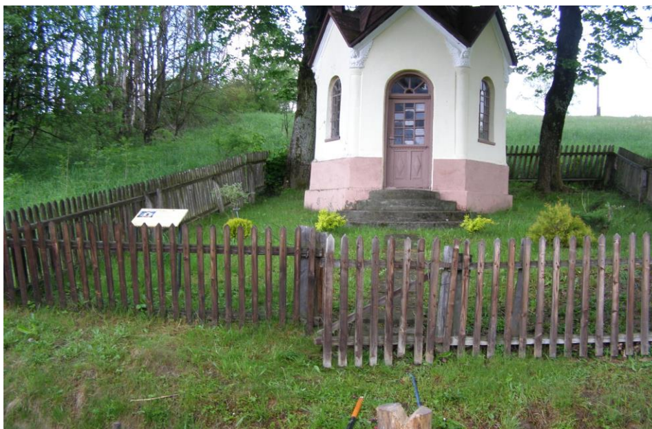
Ogrodzenie przy kapliczce w Łodynie przed rozpoczęciem prac.
