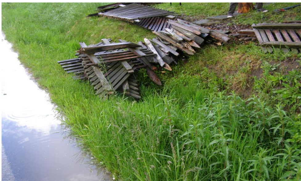
Efekt końcowy wykonania nowego ogrodzenia przy kapliczce.
