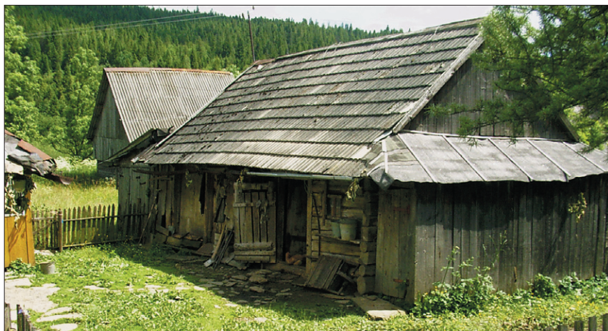
Dawna zabudowa wiejska na terenach Bojkowszczyzny, fot. Jacek Łeszega
