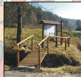
13 - Konstrukcja turystyczna w Leszczowatem, fot. Jacek Leszega
